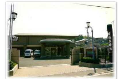
竣工後の椿園外観
